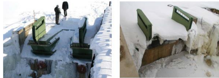
Hausse fusibles sur le barrage de Khorobrovksaya
